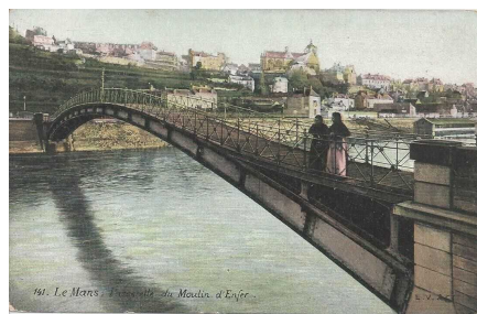
Le Mans, passerelle « chameau », 1885.(démolie en 1944) CP
